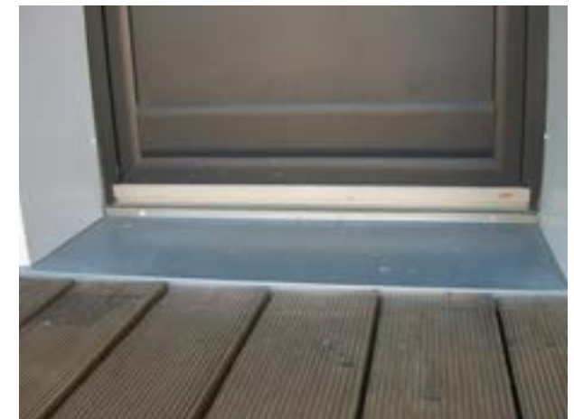
Pose d'un seuil « à la suisse » avec calfeutrement garantissant l'étanchéité à l'air et à l'eau mais non adapté aux PMR. (Crédit photo: AQC)
