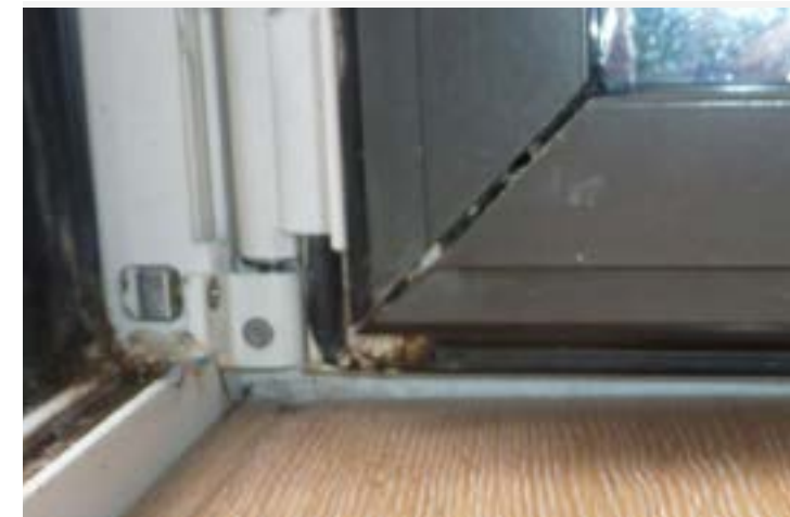
Assemblage d'angle défaillant et laissant apparaître des défauts de calfeutrement (Crédit photo: Saretec)
