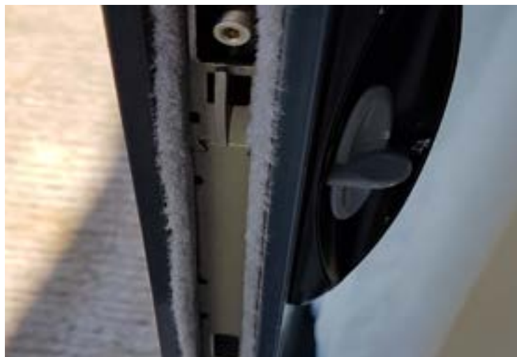
Pièces de fermetures de faible section, fragiles (Crédit photo: Saretec)
